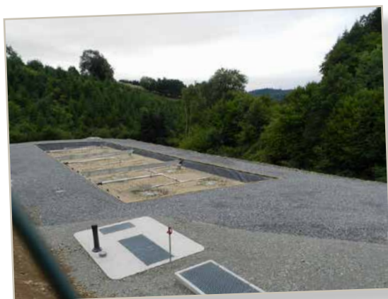
La station d'épuration
