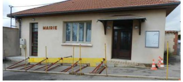
Mairie pendant les travaux d'accessibilité
