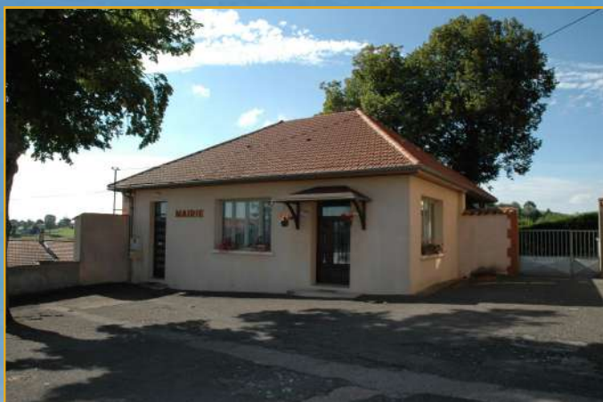
Mairie avant travaux
