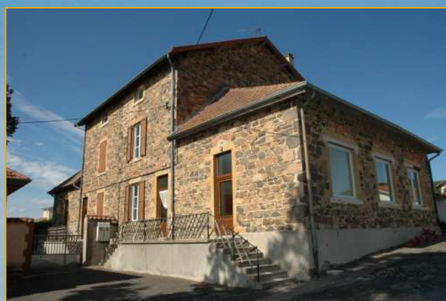
École maternelle avant travaux
